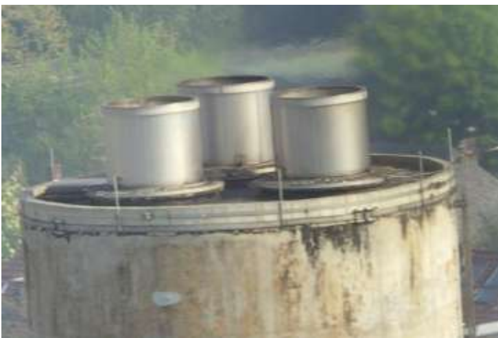
Blick vom benachbarten 160m hohen Marriott-Hotel auf den Schornstein. Es ist kein Brutplatz erkennbar.
