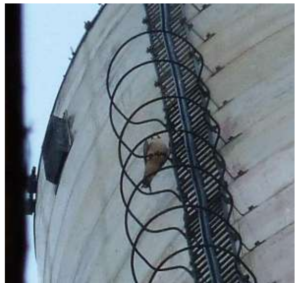
Hier ein WF auf den Steigeisen des Schornsteines.
