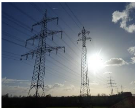
380 KV Höchstspannungsleitung
