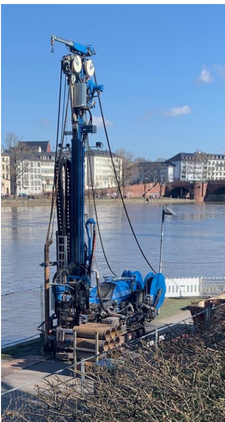
Eine der 150 Probebohrungen am Main - hier: Sachsenhäuser Mainufer - zur Grundwasser-Untersuchung für den Fernbahntunnel © G. Schmanke
