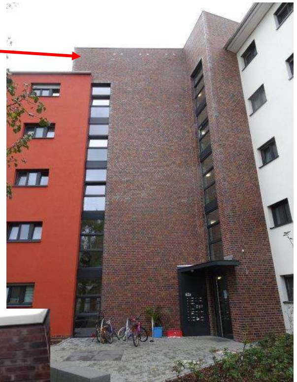
An einem Neubau in Niederrad wurde der Schwegler-Kasten Nr.17C-2fach in die Klinkerwand eingesetzt.
