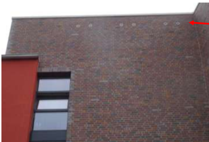
An einem Neubau in Niederrad wurde der Schwegler-Kasten Nr.17C-2fach in die Klinkerwand eingesetzt.
