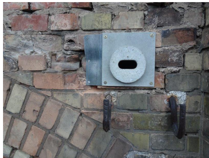
Nachher = ein Mauersegler-Nistplatz. Seitlich haben wir es noch mit einem Stück Zinkblech abgedichtet.
