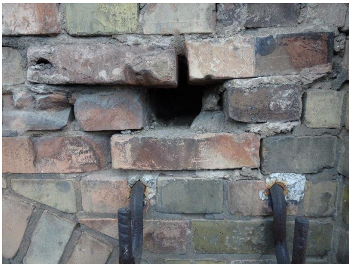
Das Mauerloch in der Fassade, vorher :
