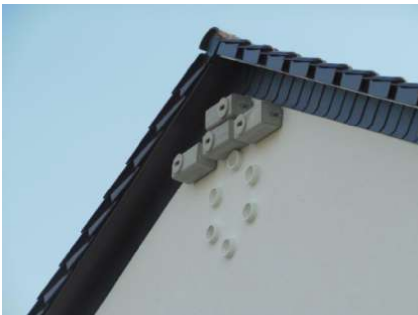
In Frankfurt-Sachsenhausen: ein Hausbesitzer hat durch seine Handwerker 4 Schwegler-Kästen Nr. 17 in den Giebel schrauben lassen.
