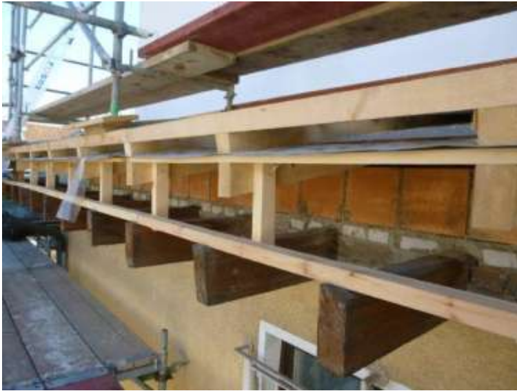
Der „Rohbau“ für die einzubauenden Nistplätze.
