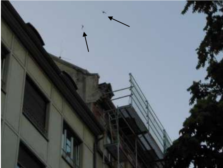
17. Juli 2014 = das eingerüstete Haus mit Segler in der Luft.
