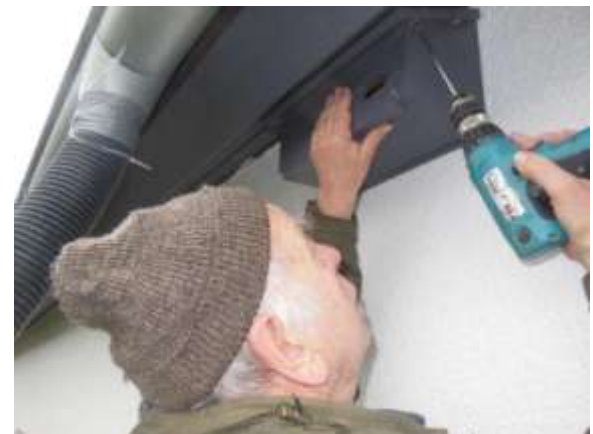
18. Dezember 2014: letzte Montagen im 3. Bauabschnitt.
