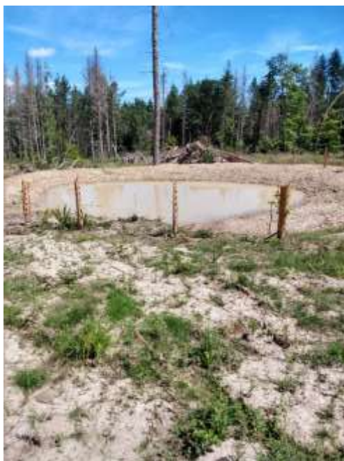
Abbildung 13: Retentions- und Versickerungsmulden bei Obernhain (Foto: BUND)
