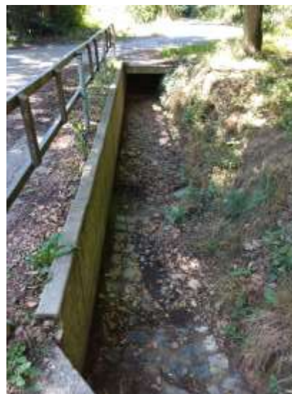
Abbildung 3: Entwässerungsbauwerk Dillingen (Foto: BUND Ffm)
